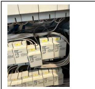
Heizungsfernsteuerung aus der Hutschiene heraus gebrochen -> muss getauscht werden
